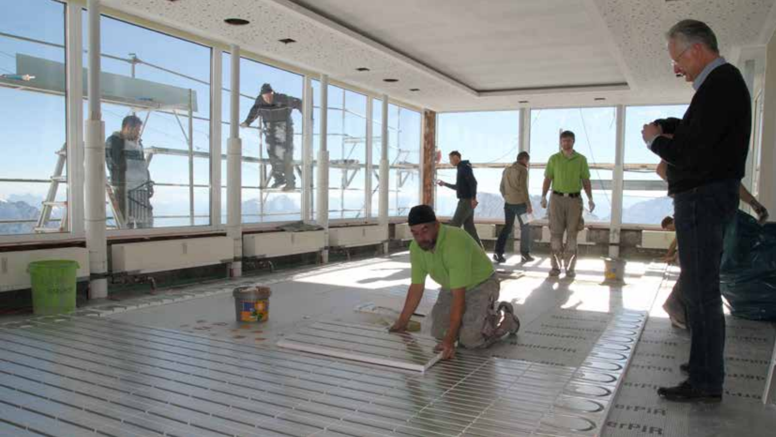
Die 30 mm dicken Rohrträgerelemente BasicLine wurden mit einem PU-Kleber auf die Dämmplatten geklebt.
