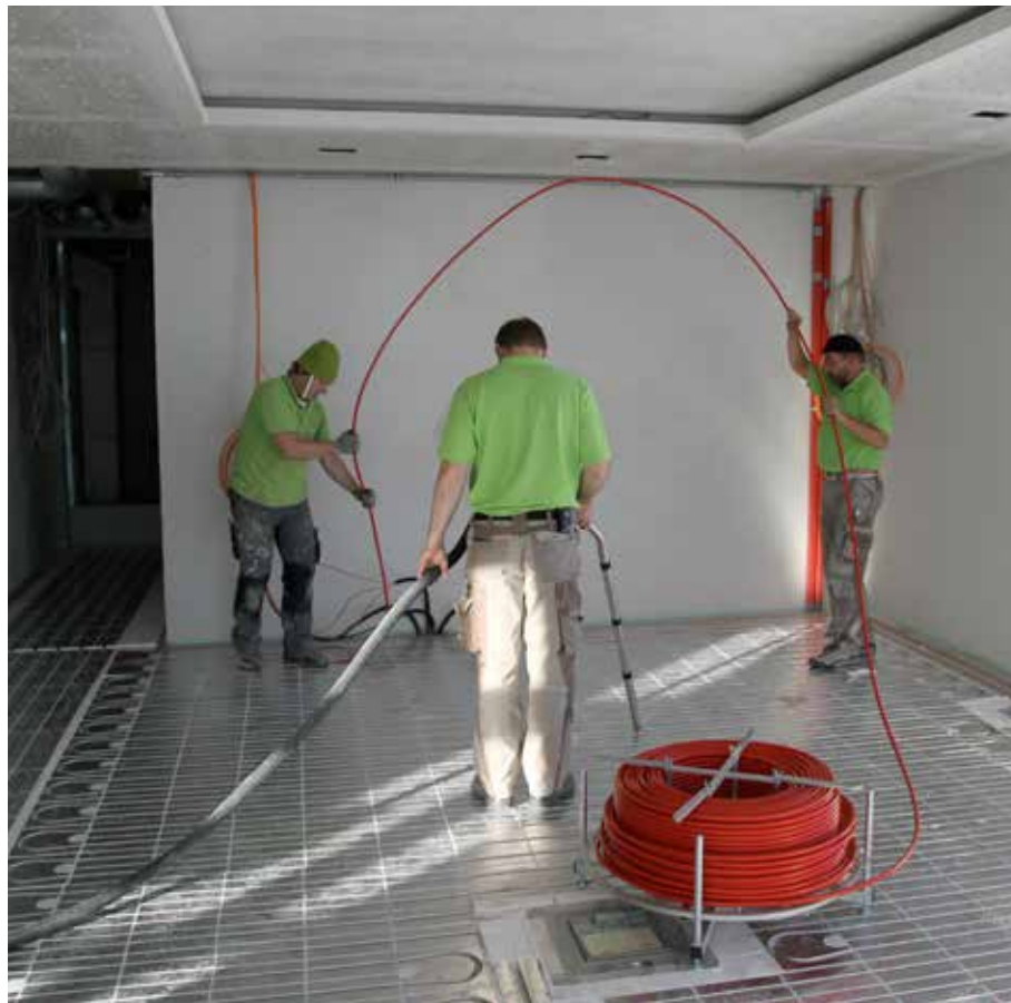
Vor dem Einlegen der Heizrohre wurden die Rohrkanäle abgesaugt, um Beschädigungen der Kunststoffrohre durch Schmutzpartikel zu verhindern.
