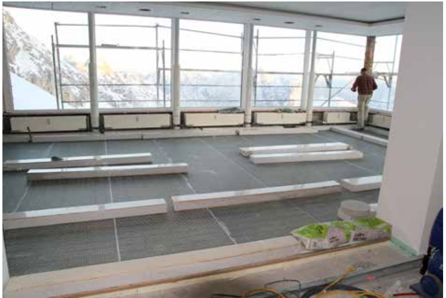
Oberer Abschluss des Heizsystem-Aufbaus ist die aufgeklebte Armierungs- und Entkopplungsmatte Prosecurefibretec.
